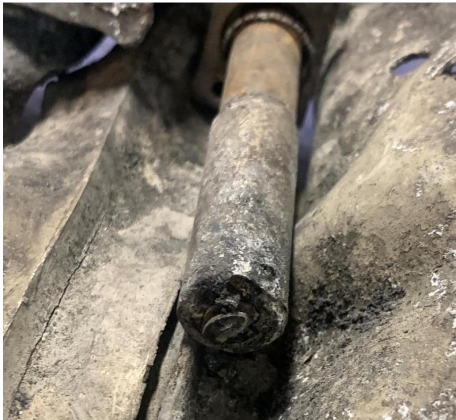
Foto 66: particolare dell' operating rod . Ram tube e shaft/acme con parte di un singolo filetto esposto del shaft/acme .
