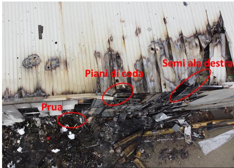
Foto 11: ripresa aerea dell'edificio con i punti di impatto evidenziati (fotogramma da video drone VVF).
