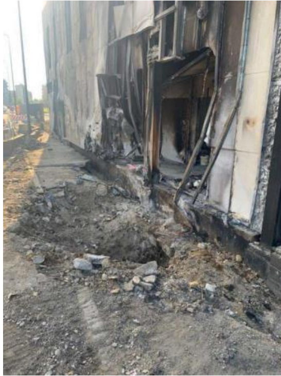
Foto 14: cratere formatosi in corrispondenza del punto di impatto al suolo, fotografato dopo la rimozione del relitto.
