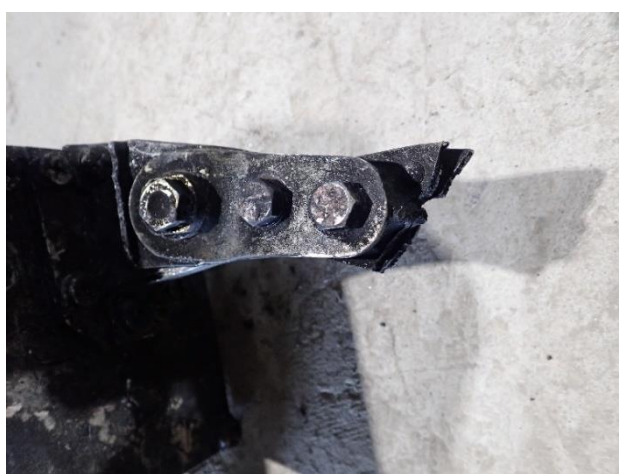
Foto 33: particolare del vincolo (parte inferiore del PTA) con porzione del punto di fissaggio alla deriva.
